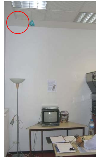
3. SDC-Salle de contrôle CHA01/CHA02
